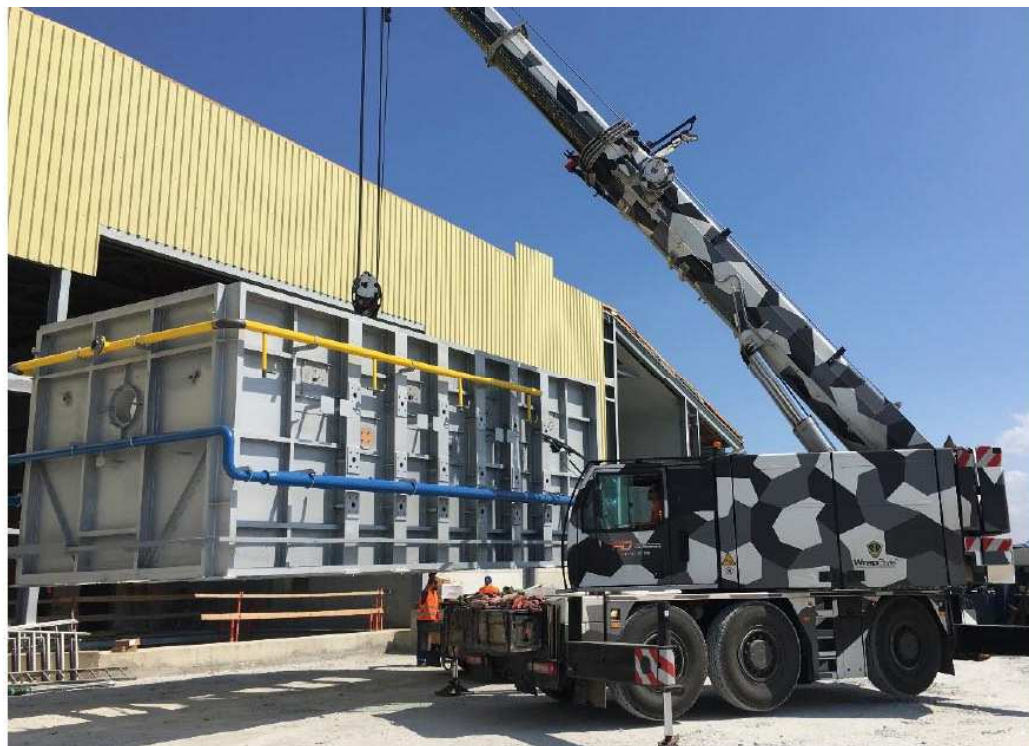
Instalace plynové pece na vanu 7 × 1,8 × 3,5 m
